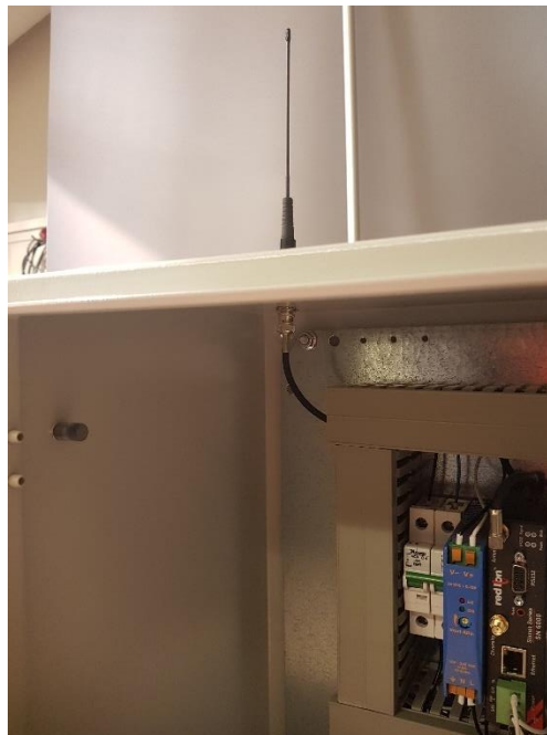
Bilde 6 SMS modul for varsling direkte til driftspersonell ved driftsforstyrrelser kommer i eget skap som plasseres ved siden av Sprinklerheat kontrollskap.
